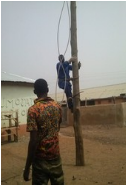
Elektrisch wordt aangelegd
